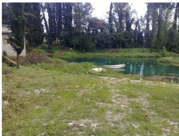
Crpna stanica Butina
